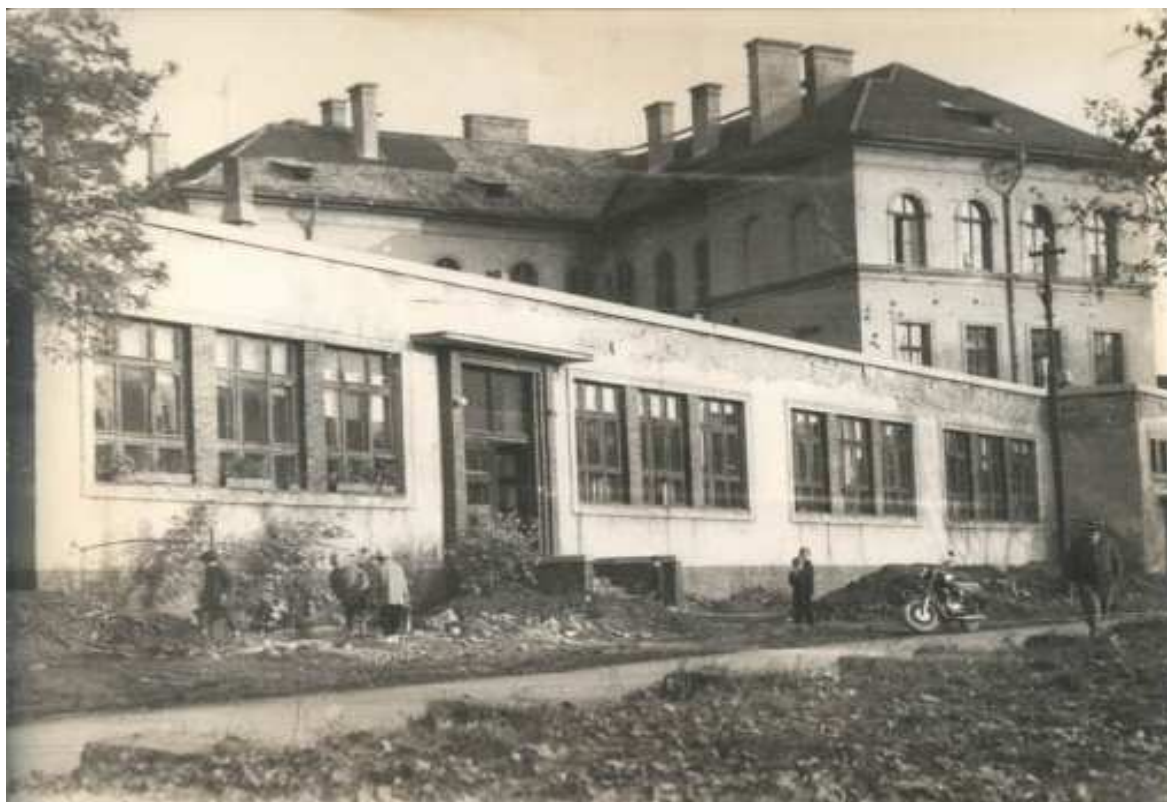
8. kép. Az iskola jelenlegi épületének oldalbejárata /1956/
